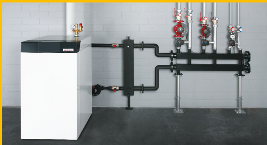
Condenserende gasketel WTC-GB met hydraulische componenten (zonder warmte-isolatie)
